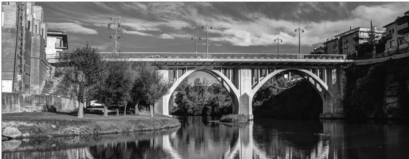
Al pont de Sant Quirze de Besora, sobre el riu Ter, s'ha eixamplat el tauler, s'han millorat dels accessos, i s'ha dotat de nou equipament i contencions al pont. DIPUTACIÓ DE BARCELONA
