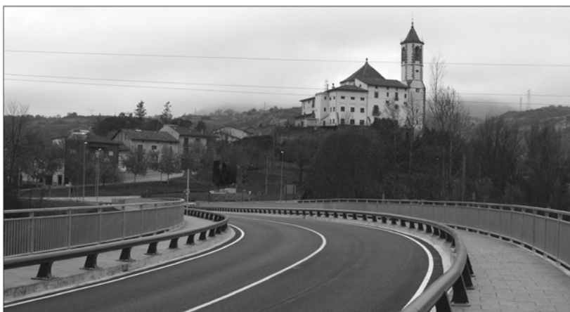
Al pont de la Gleva, entre Manlleu i les Masies de Voltregà, s'hi va haver de fer una actuació d'urgència perquè un accident de trànsit va desplaçar el tauler. Finalment, es va canviar aquesta peça per garantir la màxima seguretat i es va aprofitar per fer voreres protegides per a vianants. DIPUTACIÓ DE BARCELONA
